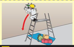
①可搬式作業台が作業の中心に設置されていなかった。 ②前工程の他業者の資材、残材が整頓されていなかった
