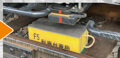
養生マットの上に転車台兼用半スリを設置する
