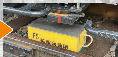
養生マットの上に転車台兼用半スリを設置する
