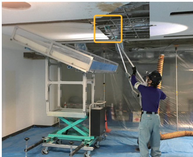
作業風景:ボードスライダーとセットで使うことで静かに解体が可能
