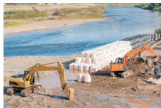
大型土のう製作
