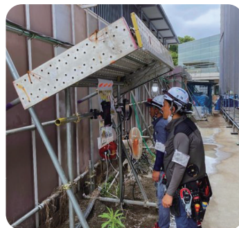
現場入場ドア付近
