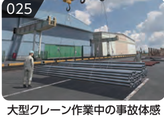
大型クレーン作業中の事故体感
