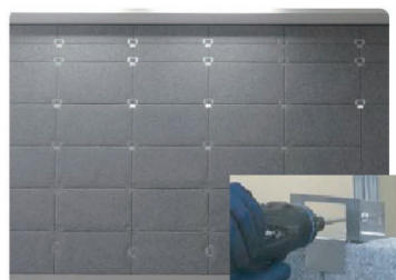
②取付金物をスタッドに ねじ止めしパネルを固定
