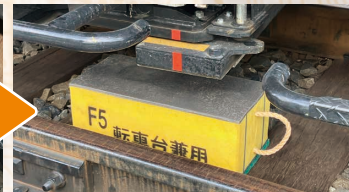
養生マットの上に転車台兼用半スリを設置する
