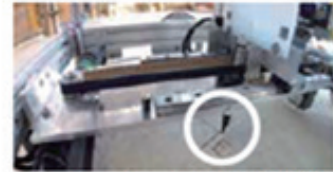
ベンプロッタによる床面墨出し
