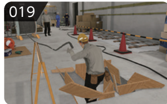
建設現場における踏み抜き災害体験
