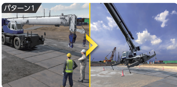
クレーンの危険体感(地盤不良)
