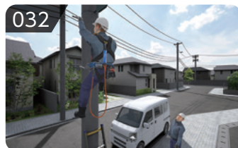
装柱金物取付作業時の危険体験
