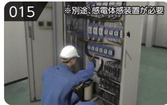
盤内配線作業中の感電
