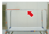
④桁面感知ロッドを設置します。
