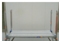
①専用手がかり棒4本を設置します。
