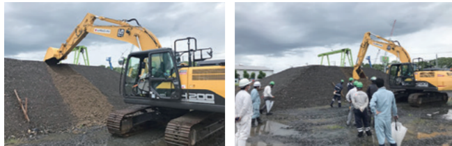
法面施工の様子
